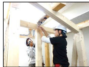
図6 電気配線工事
