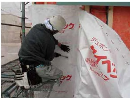
写真:透湿防水シート張りの様子
