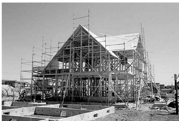
写真：在来軸組工法
