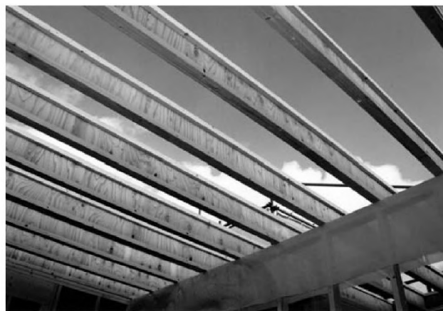
写真：枠組壁建築工法における根太施工の様子
